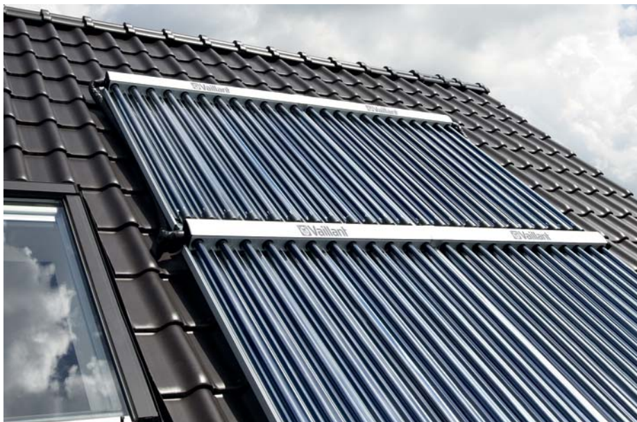
Montáž vakuových trubcových kolektorů auroTHERM exclusiv VTK 1140/2 na střechu
