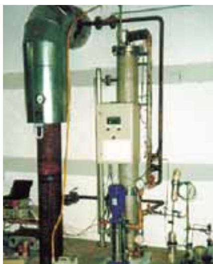
Obrázek 1: Servitec na předávací stanici soustavy zásobování teplem v Halle Tepelný výkon: 14,8 MW Objem vody: ca. 100 m 3 Zpáteční teplota: ≤ 70 °C Tlak ve zpáteční větvi: ca. 6 bar
