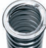
Špatně odřezaná trubka
