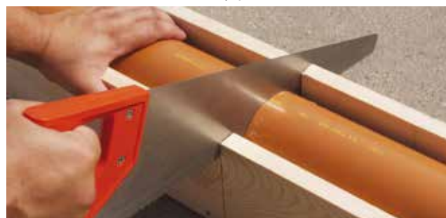
Obrázek 2 Zkracování trubky pilkou
