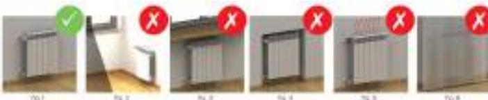
Le teste termostatiche devono essere installate fuori dai flussi di calore che circondano gli elementi riscaldanti (fig. 1) e al riparo da raggi solari (fig. 2). Evitare quindi di installare la testa termostatica sotto i ripiani (fig. 3) o in nicchia (fig. 4), all'interno del flusso dell'aria calda (fig. 5) o dietro tende (fig. 6). Queste installazioni non sono corrette in quanto la testa termostatica valuterebbe una temperatura diversa da quella presente nella stanza.
