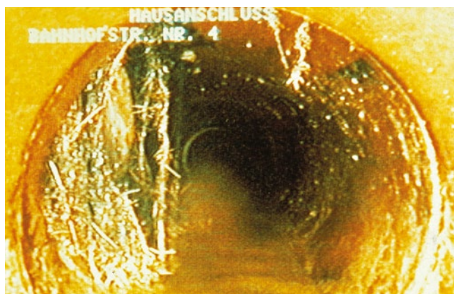
Ukázky kanalizačního potrubí se zřetelnými prasklinami (stav III)
