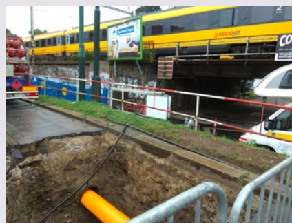
Sanace plynovodu DN 500 v centru Prahy proběhla za rušného provozu v těsné blízkosti tramvajového pásu
