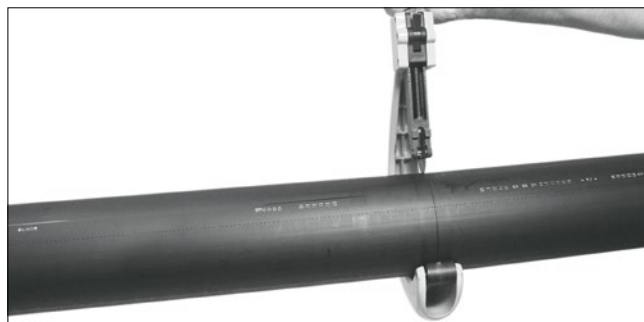
Řez potrubí ruční rotační řezačkou
