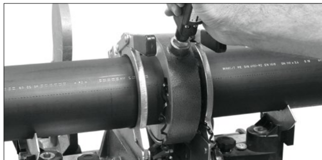
Srovnání konců potrubí integrovaným hoblíkem
