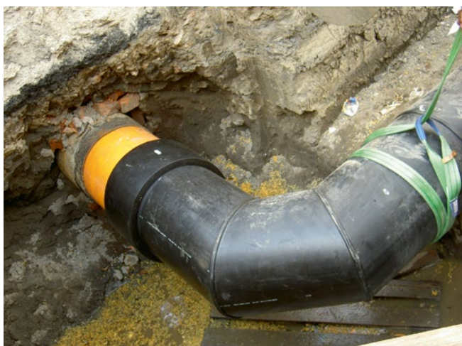
Napojení potrubí Compact Pipe na segmentový oblouk pomocí elektrospojky
