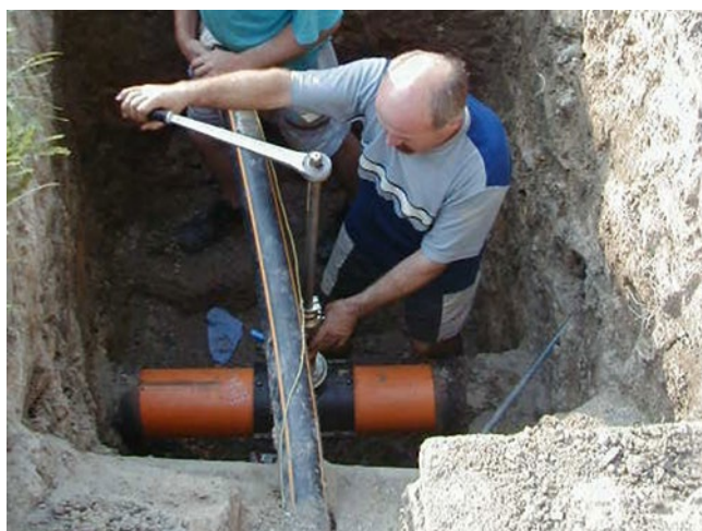
Vysazení přípojky pomocí sedlové tvarovky
