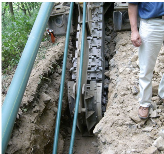
Pokládka kanalizačního potrubí SafeTech RC d140 mm a Wavin TS d140 frézováním v Friedrichsbrunn Harz a Strassberg Harz
