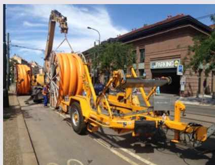
Sanace plynovodu DN 500 v centru Prahy proběhla za rušného provozu v těsné blízkosti tramvajového pásu
