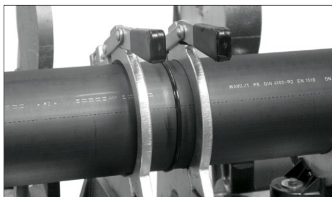
Chladnutí svařeného spoje
