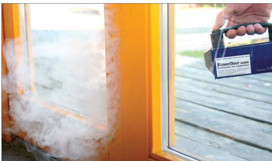
Určování netěsností mlhovým generátorem
